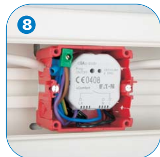
8 Einbau des Aktors in Kabelkanaldose
