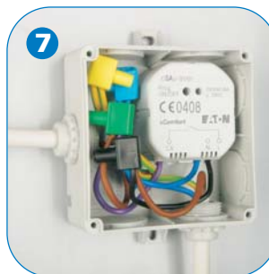
7 Einbau des Aktors in Feuchtraumdose
