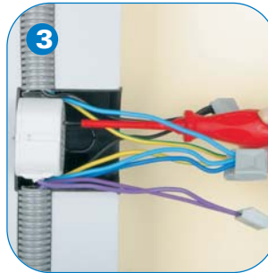
3 Verwendung von Schraub- und Steckklemmen möglich
