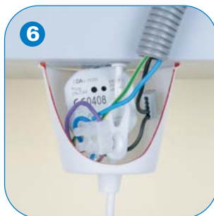
6 Einbau des Aktors in Lampenabdeckung
